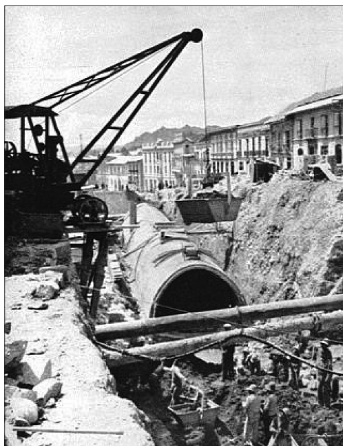
Figura 2 Proceso de construcción de la avenida Mariscal Santa Cruz y embovedado del río Choqueyapu
